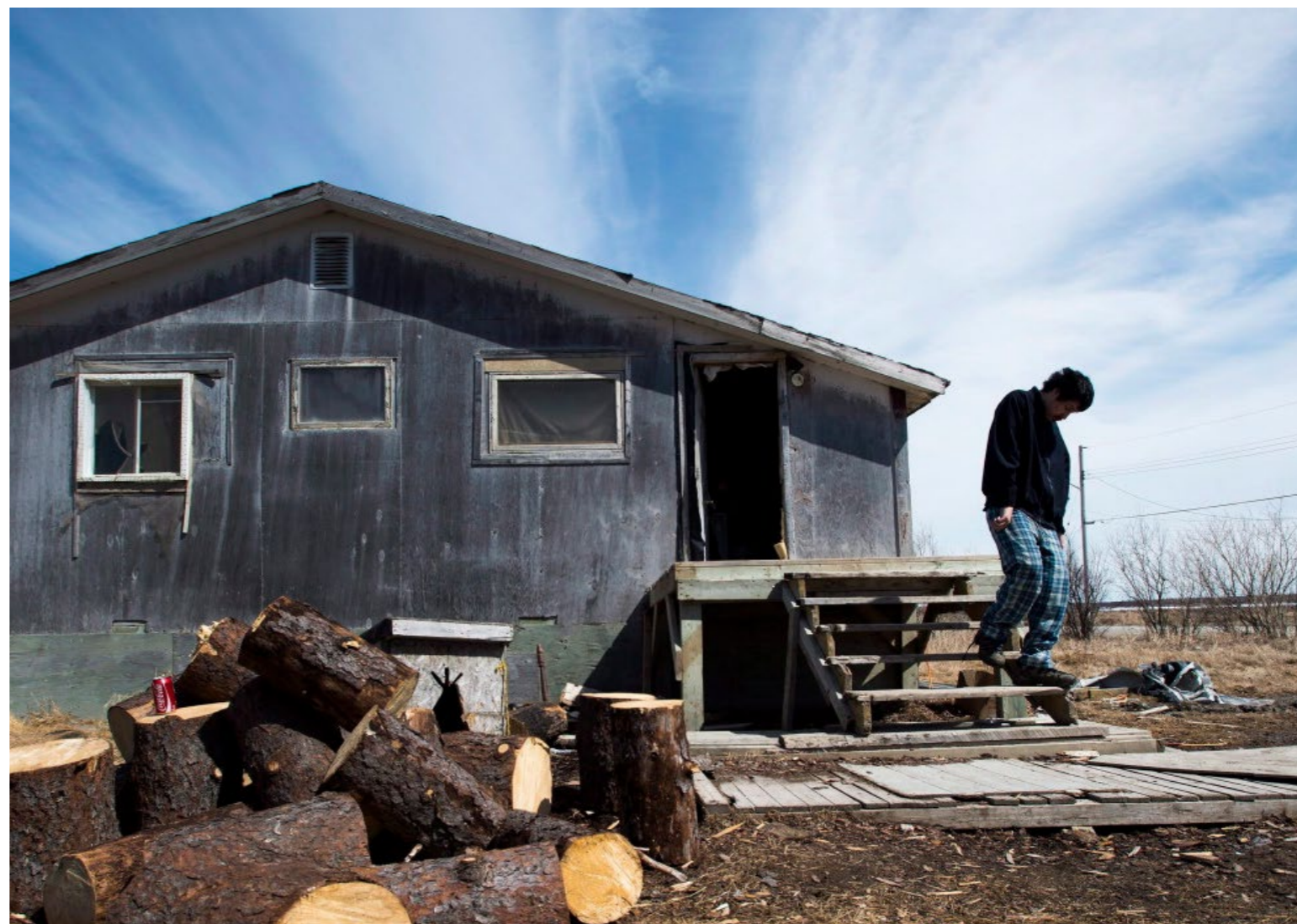
Un résident de la réserve Attawapiskat, en Ontario, quitte une maison qui a été jugée impropre à l'habitation humaine.
